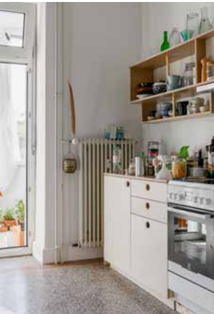
An der Elsässerstrasse 137 waren die Waschbecken in den Küchen noch gut in Schuss. Sie wurden nach der Sanierung wiederverwendet und erhielten neue Untermöbel aus Holz.
