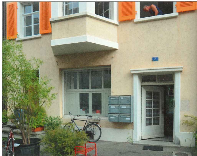
Das Haus wird in Absprache mit der Bewohnerschaft stufenweise saniert. 2017 wurden die Fenster energetisch ertüchtigt.
