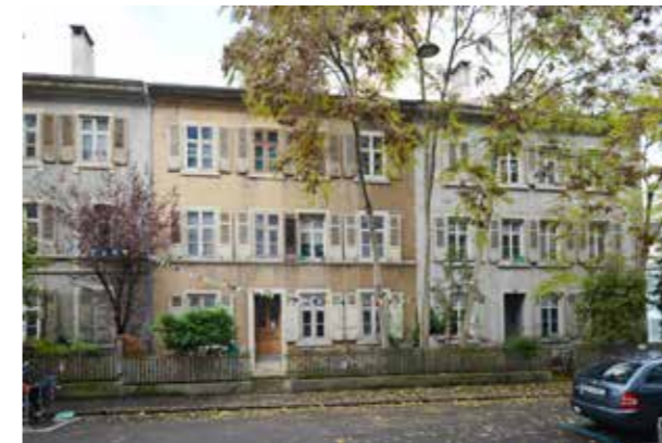
Die Wasserstrasse 21 – 25 vor...
