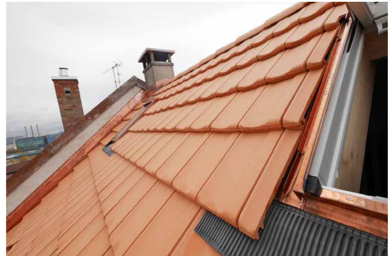
Saniertes Dach an der Wasserstrasse
