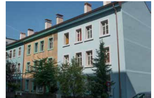
und nach der Sanierung der Hülle
